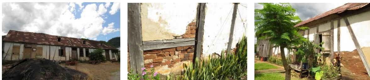
Figura 2 - Detalhes do Barracão de Nova Palmira Fonte: Fotografia elaborada pelos autores, 2016.
