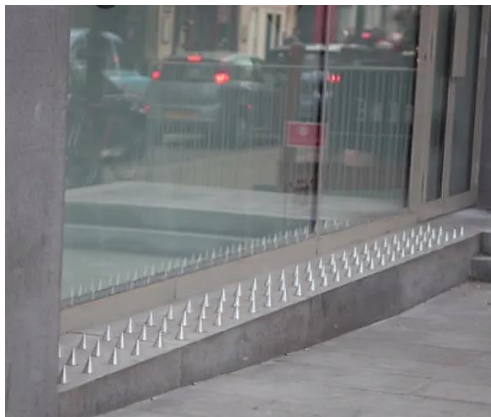
Figura 2 – Exemplo de Anti-homeless spikes (pinos anti-mendigos)
